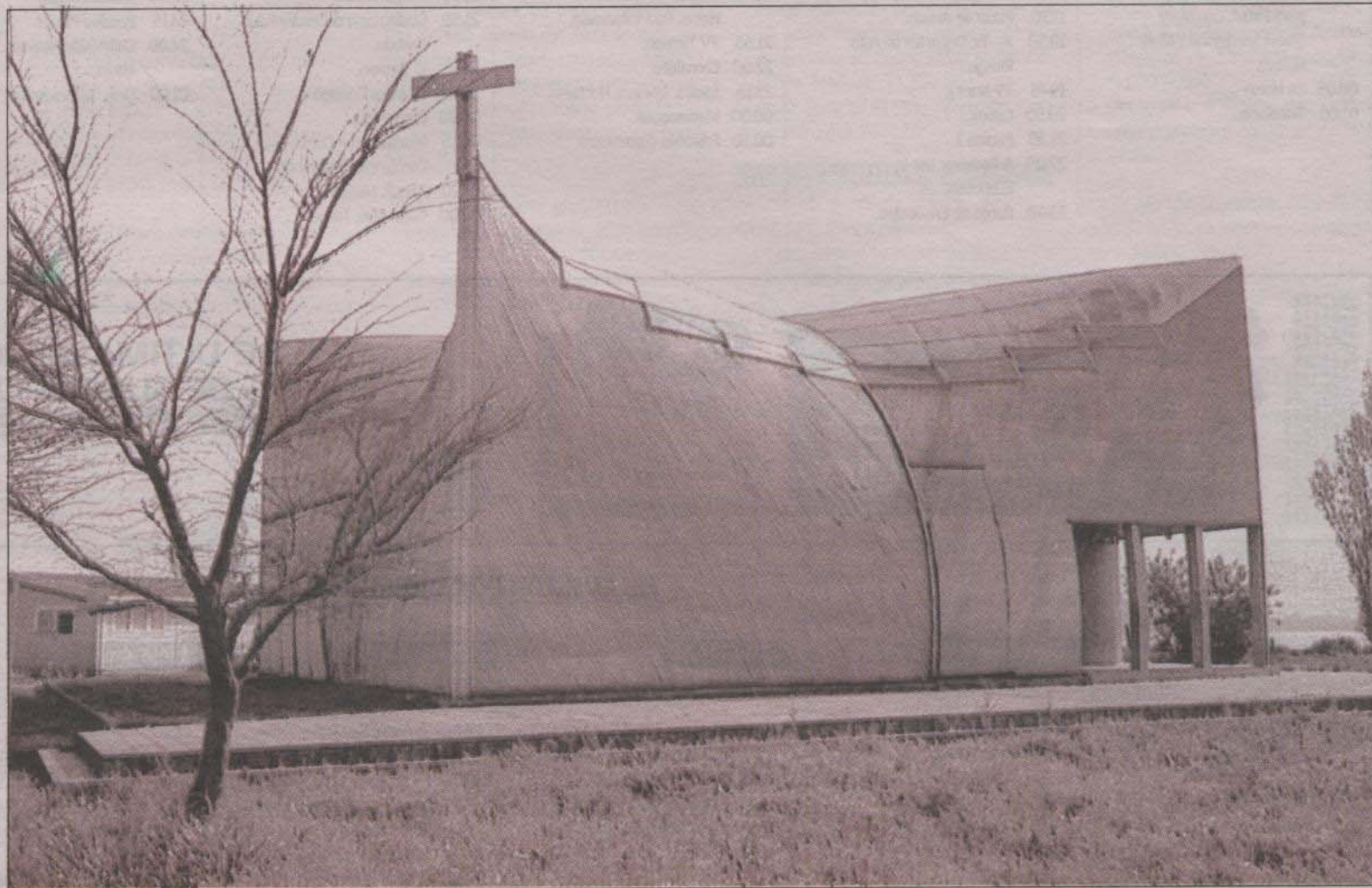
SAN PEDRO.— Iglesia de la Candelaria o iglesia San Pedro, construida en 1961 en San Pedro, Concepción, como parte de los talleres de reconstrucción de iglesias en el sur, luego del terremoto de 1960.
