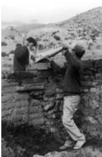
**Foto 5:** Técnica actual de construcción con moldes para adobes *in situ*, Pedernal.
